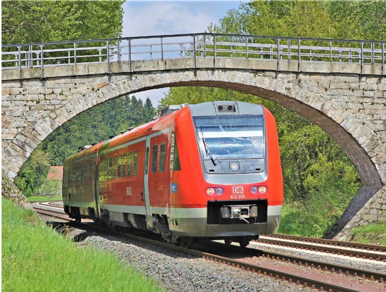
Beispiel: Brücke bei Kirchenlamitz
